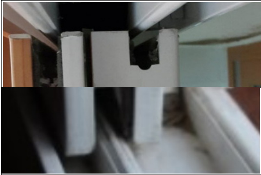
〈그림 5〉 창틀에 비해 창을 작게 제작해서 창호탈락 및 소음(외기) 유입
