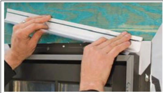
돌출 상부 flashing 작업
